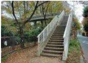
<以前の歩道橋>
